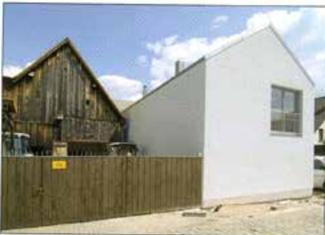
Haus und Hof - Einfamilienhaus in Beilngries Architekten Neufürger, Bohmert und Müller; Foto: Henning Koepke
